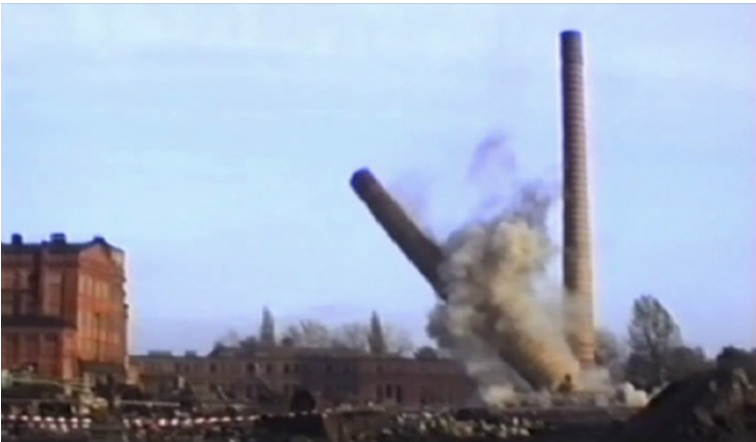
Abb. 4: Ikonisches Bild des Abbruchs: Sprengung auf dem Gelände der Brikettfabrik. © Laubuscher Heimatkanal, 19. November 1993.
